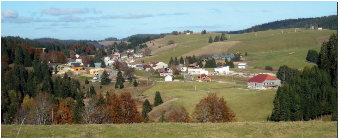
Vue sur le village depuis « sur la Semine »
