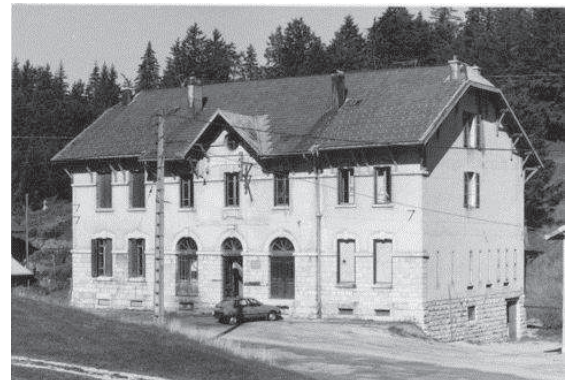
Bâtiment principal du chalet modèle
